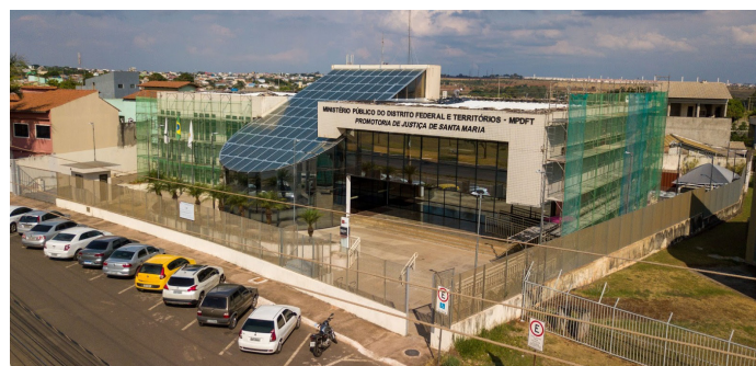
Cobertura e fachadas do edifício das PJs de Santa Maria foram reformados.
