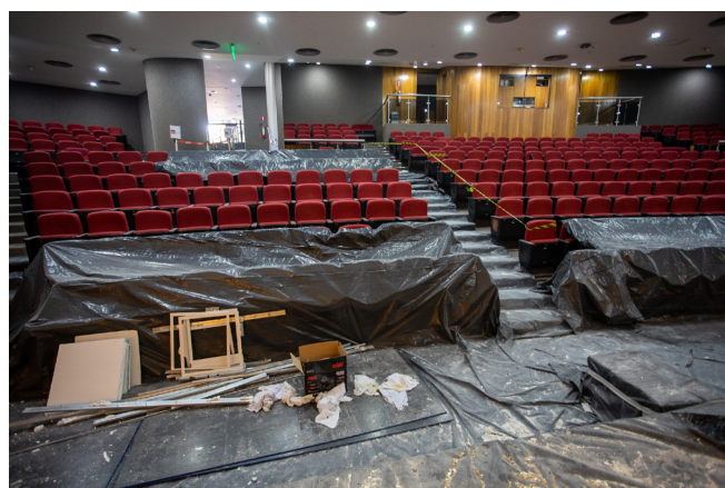
Obras no edifício-sede garantiram modernização dos elevadores, recuperação da laje de segurança e implantação do sistema de ar condicionado individualizado no auditório
