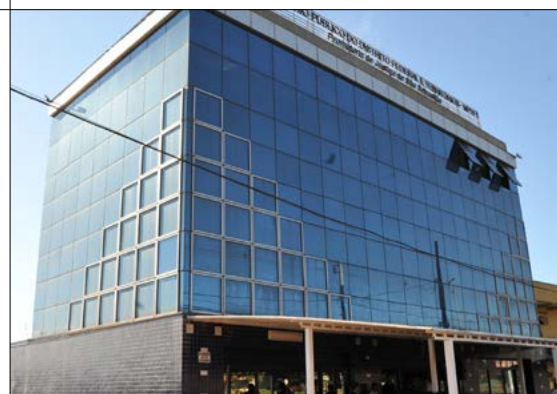
A Promotoria de Justiça de São Sebastião ganhou novas instalações
