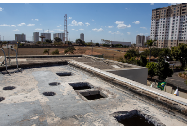
Obras de reservatórios pluviais em Samambaia
