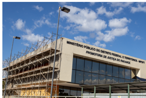
Recuperação da fachada externa no edifício do Paranoá.
