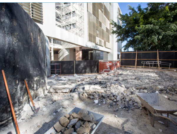
Obras na Sede
